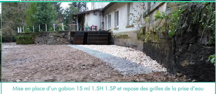
Mise en place d'un gabion 15 ml 1.5H 1.5P et repose des grilles de la prise d'eau
